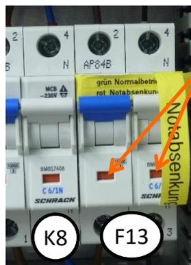
Der **Schalter F13** ist eingeschaltet und somit der Notabsenkbetrieb aktiv
